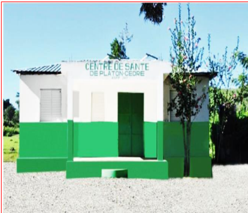
Centre de Santé construit en 2020 à Anse-à-Pitres par le BMPAD.
