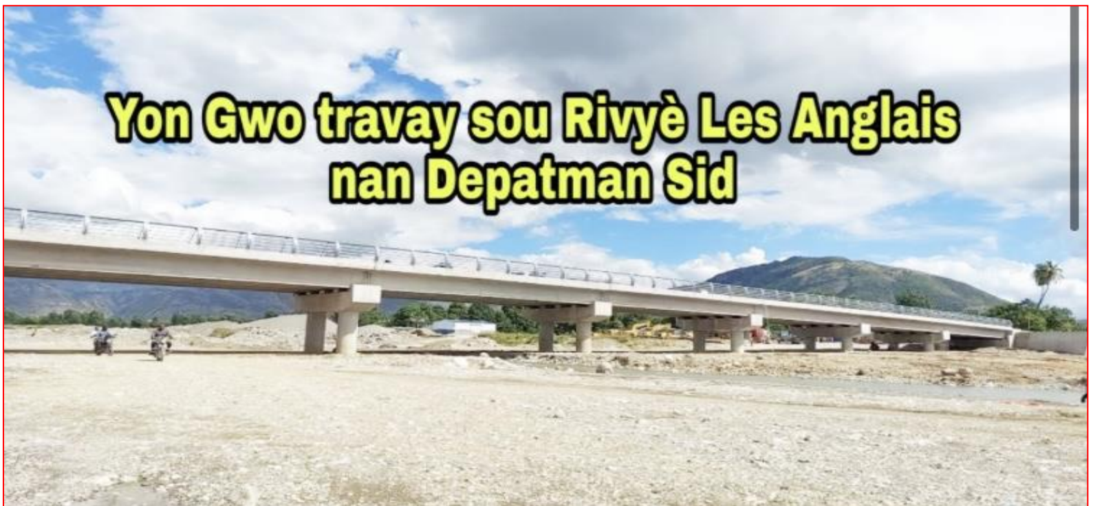
Le pont jeté sur la Rivière des Anglais, le plus grand pont d'Haïti. Construit avec des fonds du Trésor Public et inauguré le 4 Février 2022.
