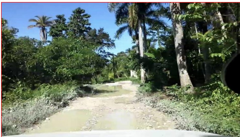
Route départementale 402 : Jacmel à Thiotte en passant par Belle-Anse.
