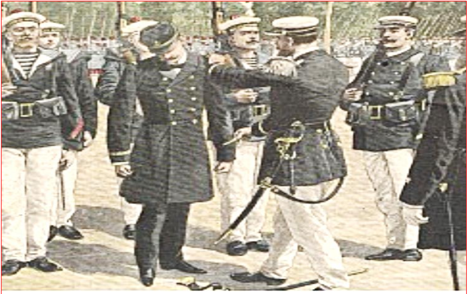
Dégradation publique d'Ullmo, Place Saint Roch, Toulouse, France, 1910.
