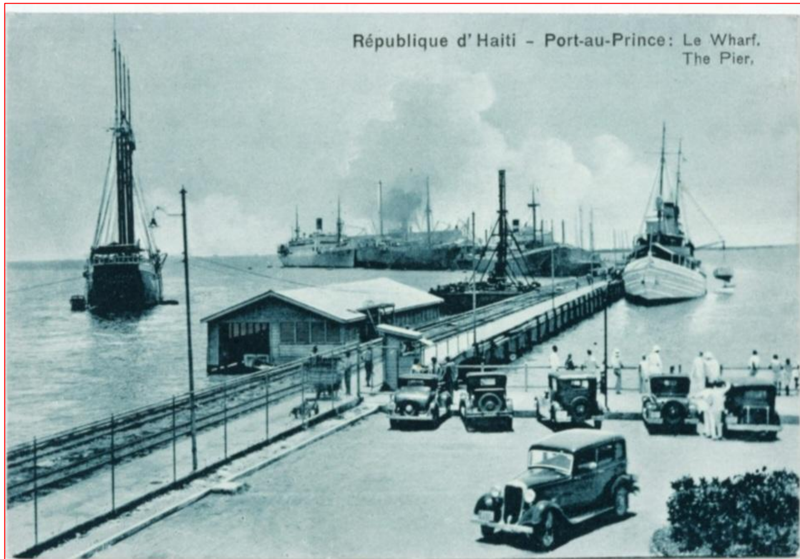
Le premier wharf moderne d'Haïti, construit en béton armé à la capitale en 1929 sous l'occupation
