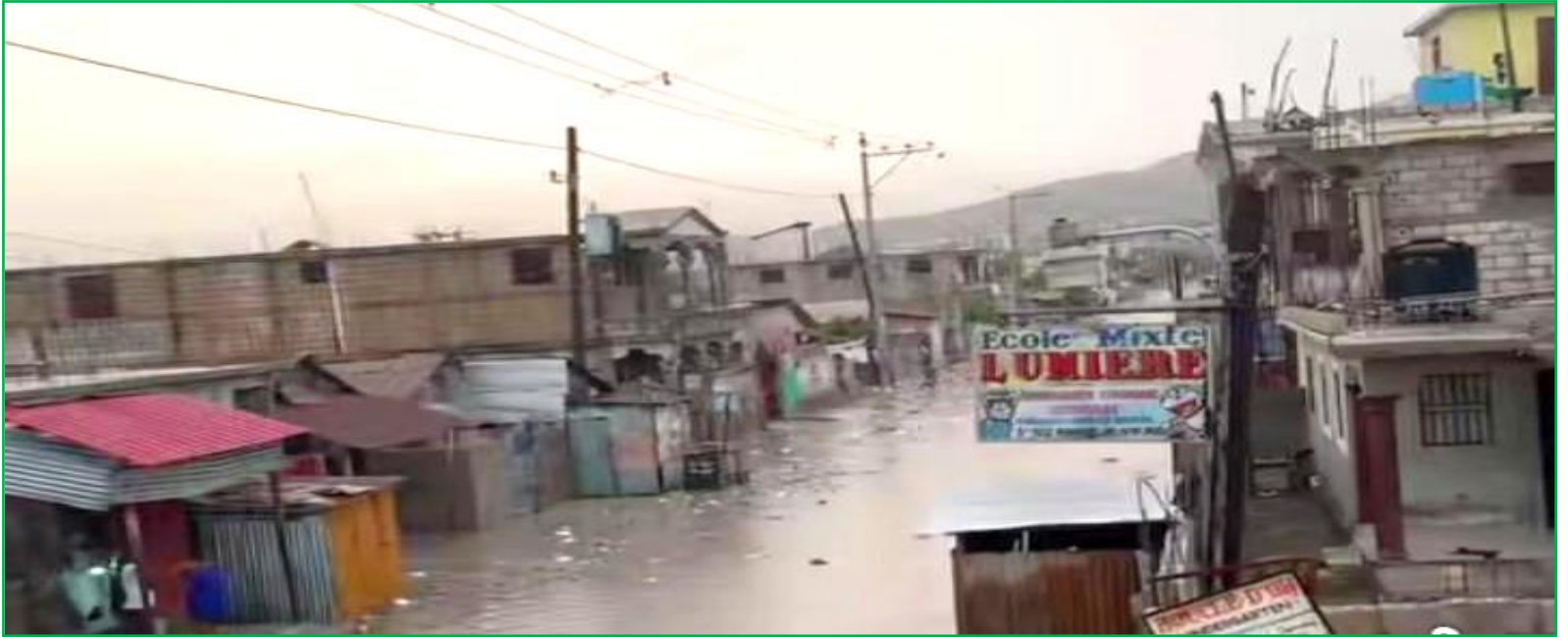
La ville des Gonaïves encore sous les eaux. 2 Septembre 2026
