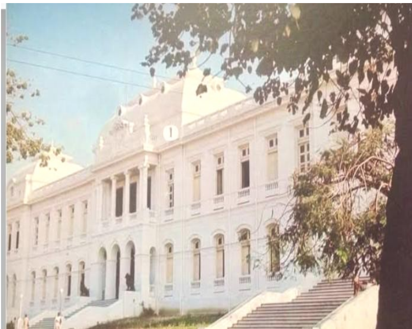
Le palais de Justice de Port-au-Prince avant le séisme du 12 janvier 2010
